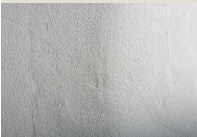
Izliekta aizšpaktelētā šuve spēcīgā sānu apgaismojumā.
