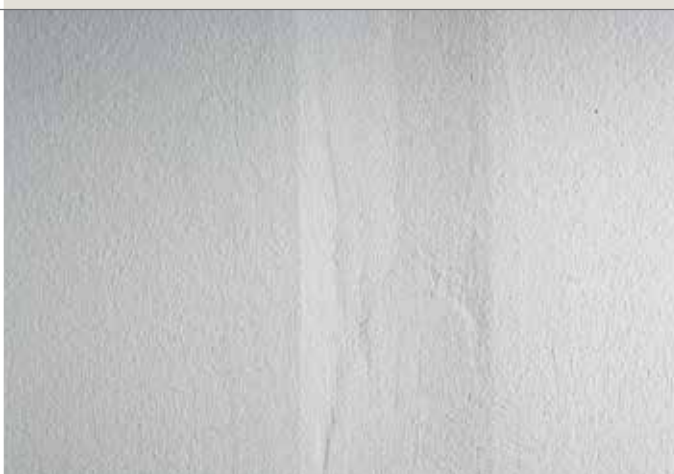
Izliekta aizšpaktelētā šuve spēcīgā sānu apgaismojumā.
