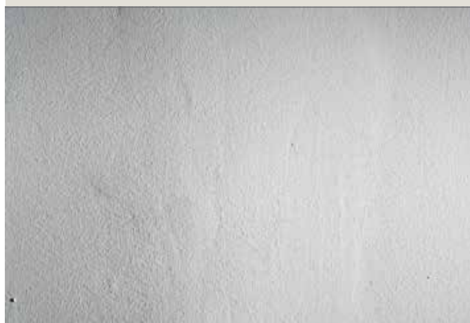
Izliekta aizšpaktelētā šuve zemā sānu apgaismojumā.
